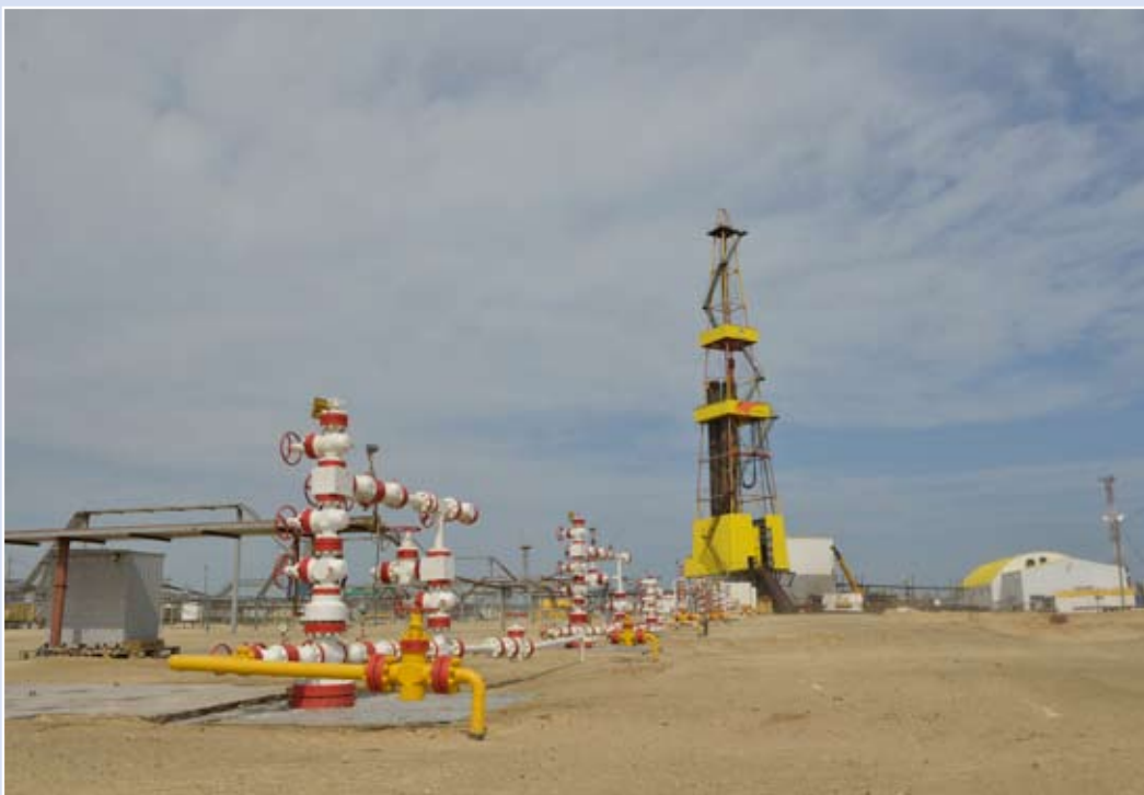
Действующий береговой комплекс нефтегазоконденсатного месторождения Одопту-море
