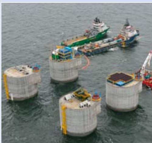
Установка основания гравитационного типа морской ледостойкой добычной платформы «Беркут» на месторождении Аркутун-Даги (проект «Сахалин-1»)
