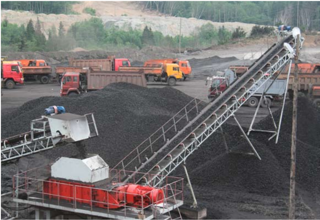
Транспортный конвейер переработки угля – в действии
