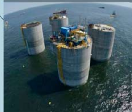
ОСНОВАНИЕ ГРАВИТАЦИОННОГО ТИПА ПЛАТФОРМЫ «БЕРКУТ»
