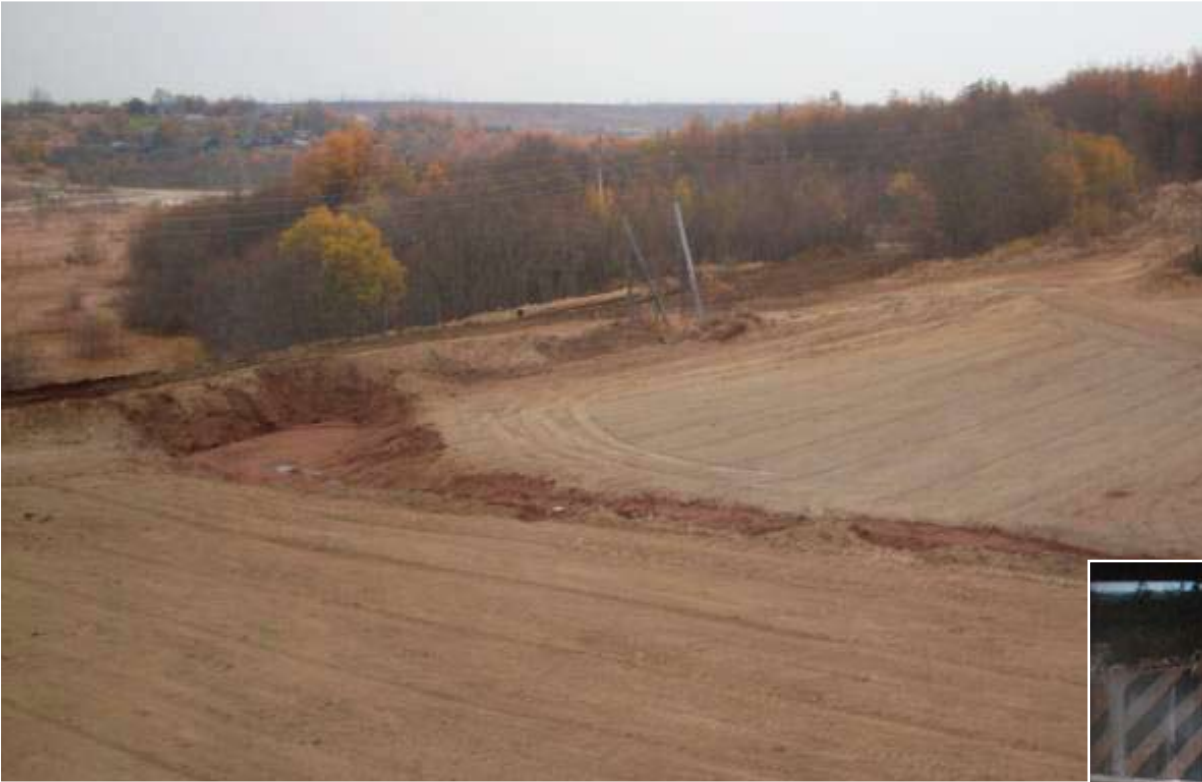
Рекультивация загрязненных нефтью земель в районе с. Вал (север Сахалина) с использованием торфяного сорбента
