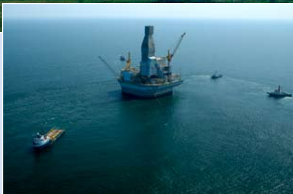
Морская добывающая платформа «Орлан» (проект «Сахалин-1»). Эта сталебетонная конструкция, на которой размещены буровой и жилой модули, используется для разработки юго-западной части месторождения Чайво. Основание «Орлана» легко выдерживает натиск льда и гигантских торосов, достигающих высоты шестиэтажного дома
