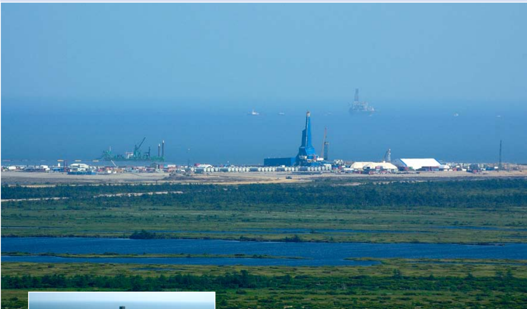
Наземная буровая установка «Ястреб» для бурения с берега наклоннонаправленных скважин с отходом забоя от вертикали до 11 км. Спроектирована специально для проекта «Сахалин-1» и является одной из наиболее мощных наземных буровых установок в отрасли
