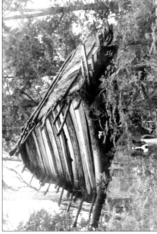
Рис. 44. Амбар на сваях для хранения продуктов (нанайцы, с. Кондон, 1939 г). (Альбом В.К. Абрамова № 14638).
