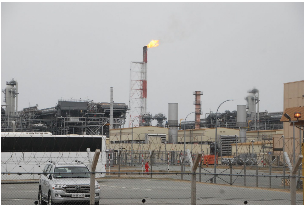
Завод по производству сжиженного природного газа (СПГ)
