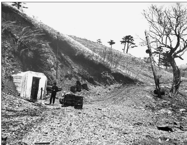
Илл. 6. Гидрофизическая обсерватория, вход в штольню. 1966 г.
