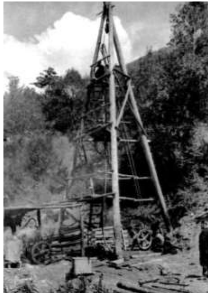
Рис. 63. Колодец Синегорского источника (сверху), бурение наклонной разведочно-эксплуатационной скважины № 8 (снизу)
